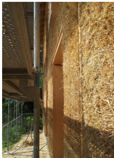
Abbildung 2: Strohwand im eingebauten Zustand
