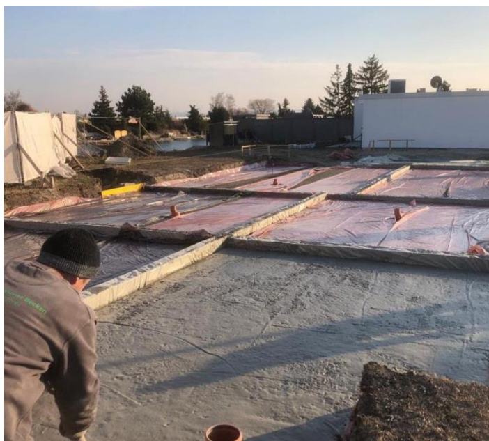
Abbildung 7: Vor-Ort-Foto der Bodenplatten Dämmung-Anwendung von Airium – Quelle: HOLCIM Beton GmbH
