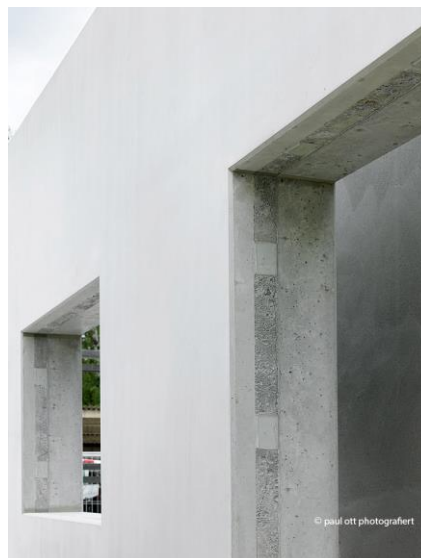
Abbildung 3: Foto eines mit Airium gefüllten Sandwichwandelements – Quelle: HOLCIM Beton GmbH
