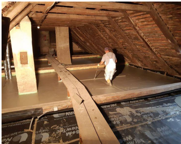
Abbildung 6: Vor-Ort-Foto der Dachbodendämmung-Anwendung von Airium – Quelle: HOLCIM Beton GmbH
