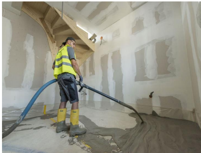
Abbildung 5: Vor-Ort-Foto der Ausgleichsschüttungs-Anwendung von Airium – Quelle: HOLCIM Beton GmbH
