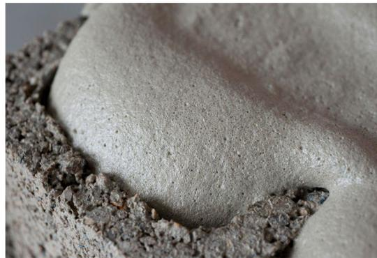
Abbildung 2: Foto einer Zelle eines Leichtbetonsteins, die mit Airium gefüllt wird (BlockFill-Anwendung) – Quelle: PERLMOOSER Beton GmbH
