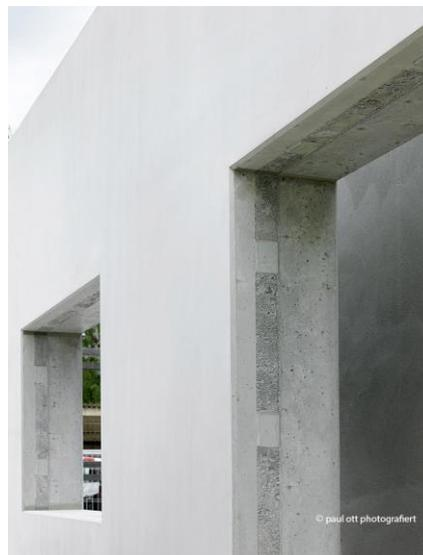
Abbildung 3: Foto eines mit Airium gefüllten Sandwichwandelements – Quelle: PERLMOOSER Beton GmbH
